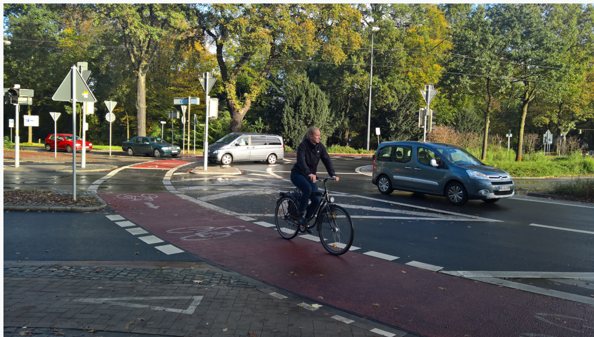
Ilustracja 8: Duże rondo z wydzielonym pasem ruchu dla rowerów w ramach pasa ruchu, opracowanie własne
