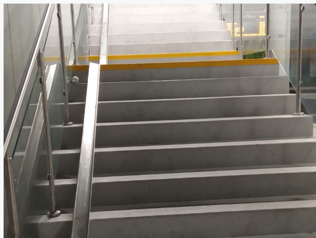
Ilustracja 39: Prowadnica rowerowa na schodach z zachowaniem odstępu 30-40 cm od ściany
