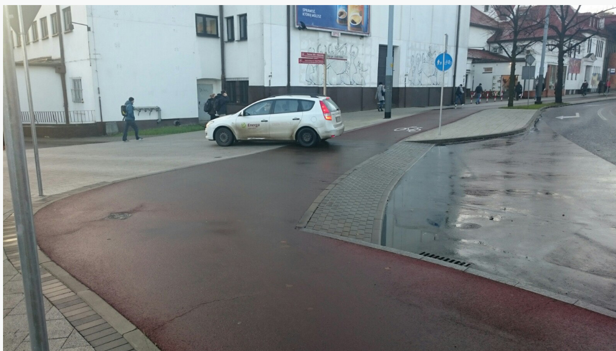
Ilustracja 15: Podwyższenie niwelety drogi rowerowej na przecięciu dwóch ulic, opracowanie własne
