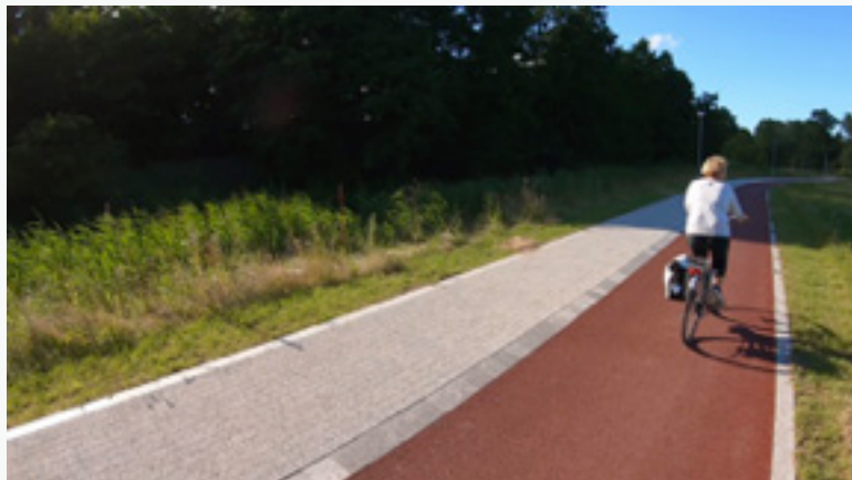
Ilustracja 19: Separacja ruchu rowerowego od pieszego, zastosowane inne rzędne chodnika, opracowanie własne
