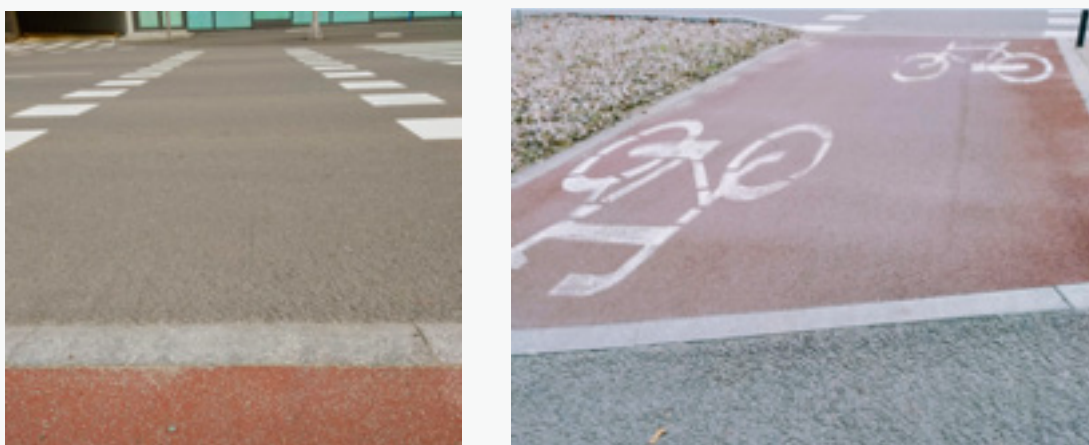
Ilustracja 16: Minimalizacja różnic w poziomach nawierzchni na przejazdach, opracowanie własne
